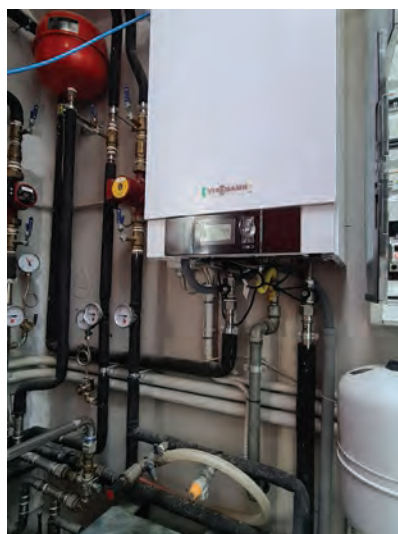
Fig. n. 1, 2 e 3: impianto con pompa di calore water/water e caldaia a condensazione integrata con impianto solare termico (da notare la presenza della valvola di sicurezza e del vaso di espansione per ogni circuito: caldaia, pompa di calore e circuito solare)
