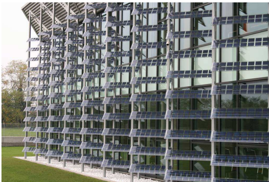
Fig.22 – Esempio di installazione idonea alla classificazione dell'impianto fotovoltaico nella categoria "su edifici"
