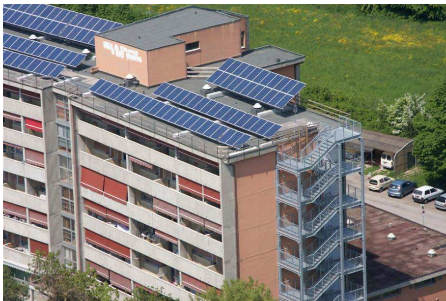
Figura 5 - Esempio di installazione non idonea alla classificazione dell'impianto fotovoltaico nella categoria "su edifici" – Motivazione: l'elemento perimetrale non può essere considerato balaustra e la quota massima dei moduli supera i 30 cm.
