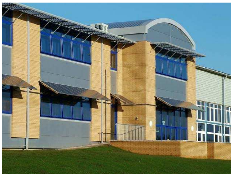
Fig. 21 – Esempio di installazione idonea alla classificazione dell'impianto fotovoltaico nella categoria "su edifici"
