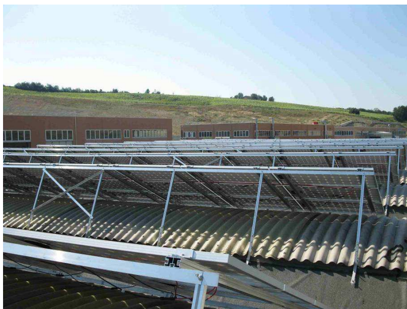
Figura 17 (a e b) - Esempio di installazione non idonea alla classificazione dell'impianto fotovoltaico nella categoria "su edifici" – Motivazione: alcune file di moduli fotovoltaici non sono appoggiate alla superficie di copertura.
